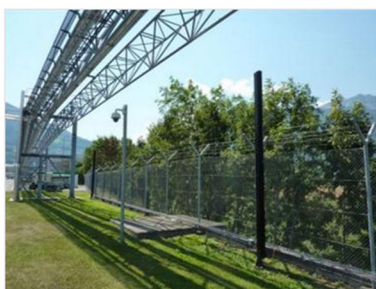
DÉTECTION D'INTRUSION PÉRIMÉTRIQUE
